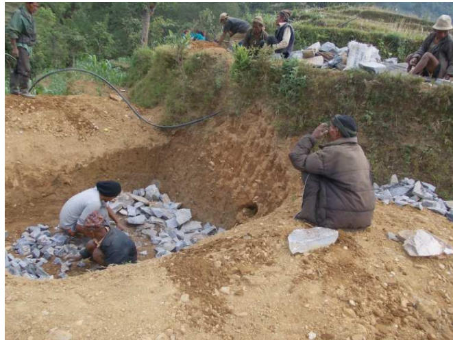
Terrassement pour le futur réservoir.
