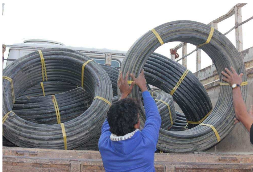
Chargement des tuyaux
