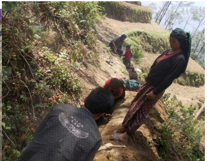
Préparation de la fouille pour les tuyaux
