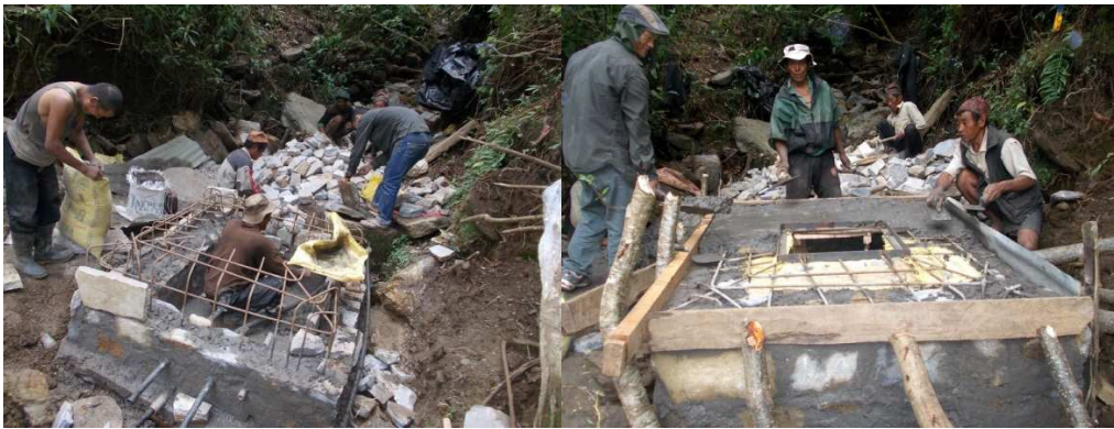
Construction du captage de la source.
