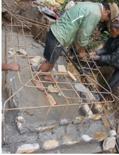
Construction du captage de la source.
