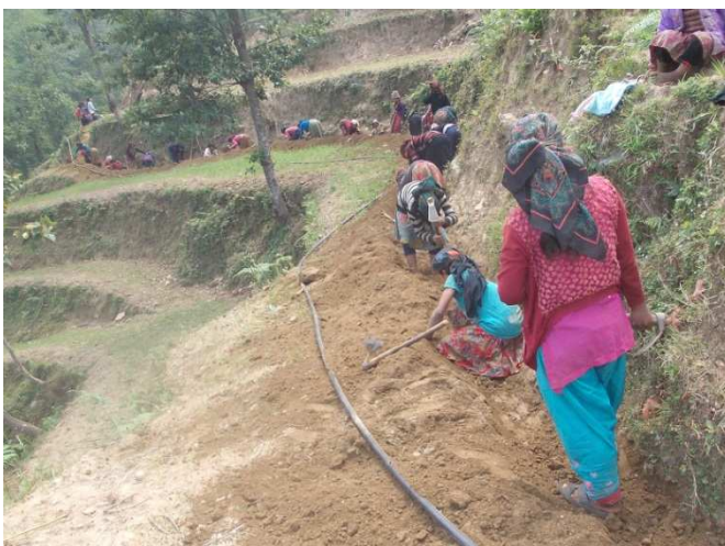
Préparation de la fouille pour les tuyaux
