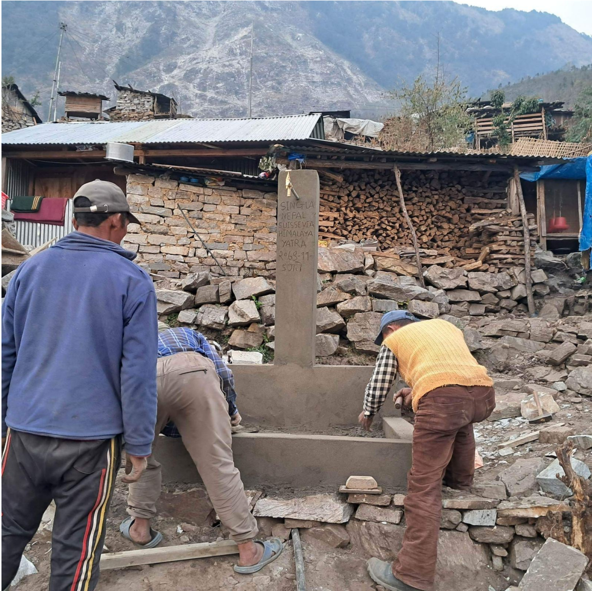
Travaux à Kerauja
