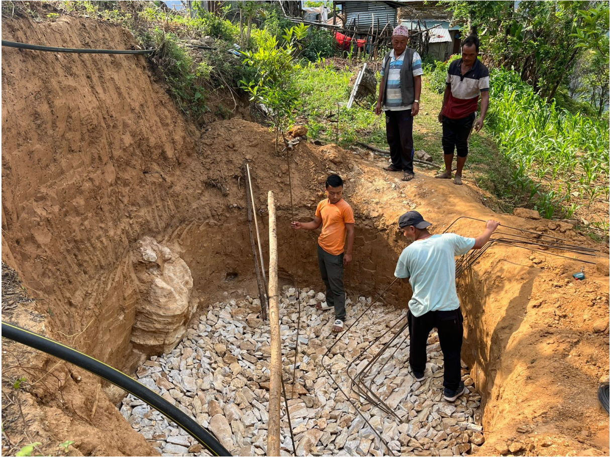
Travaux pour le réservoir de Tukrang
