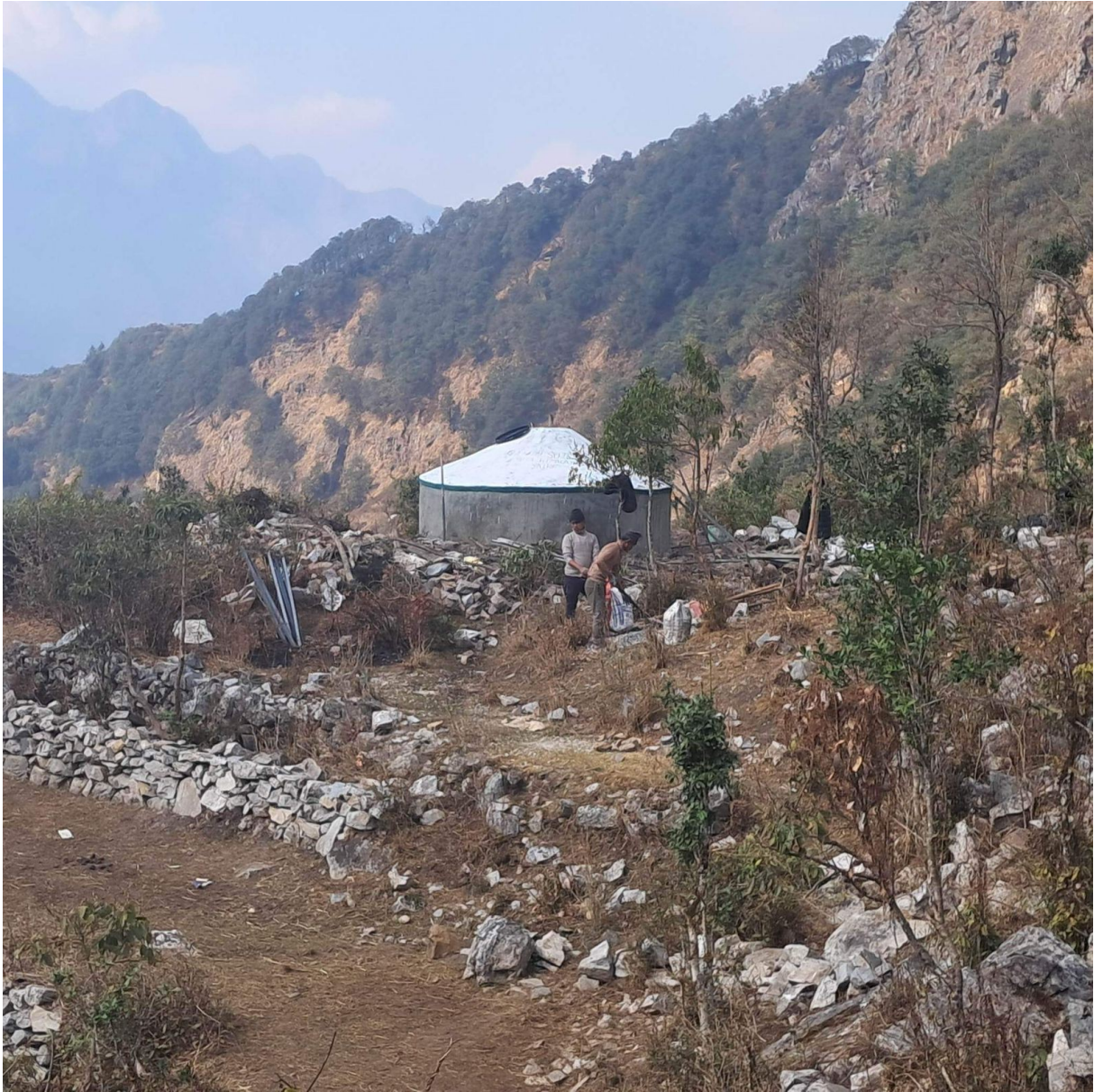
Le réservoir de Kerauja
