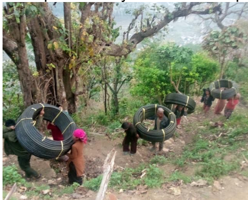
Transport des tuyaux et travaux pour le réservoir de Tukrang
